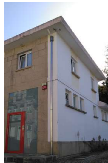
82 | Cobertura com recolha de águas pluviais
