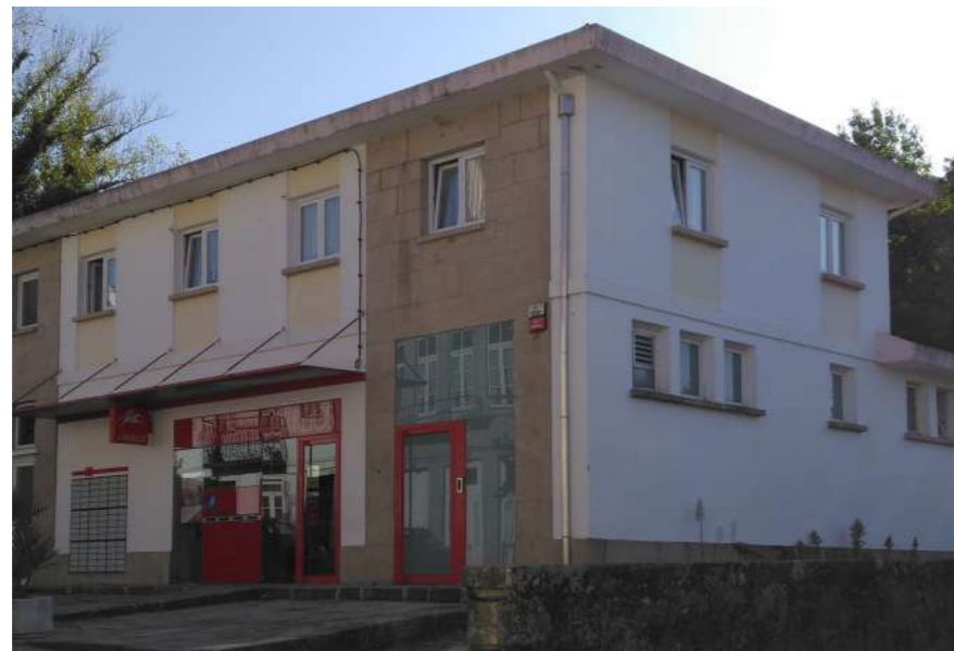
73 | Edifício em bom estado de conservação
