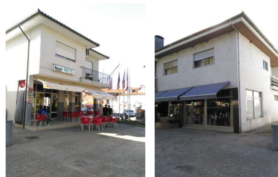
88 | Fachadas com toldo de sombreamento associado ao estabelecimento do piso térreo
